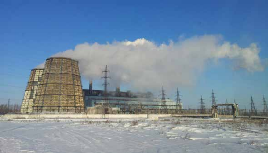
Un impianto industriale nei dintorni di Stepnogorsk
