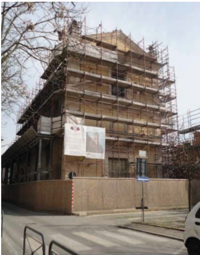
Consolidamento esterno della Chiesa del Rosario (Pinti)
