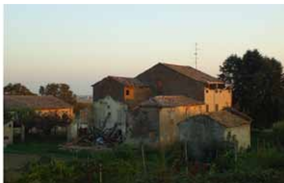
Dopo il terremoto
