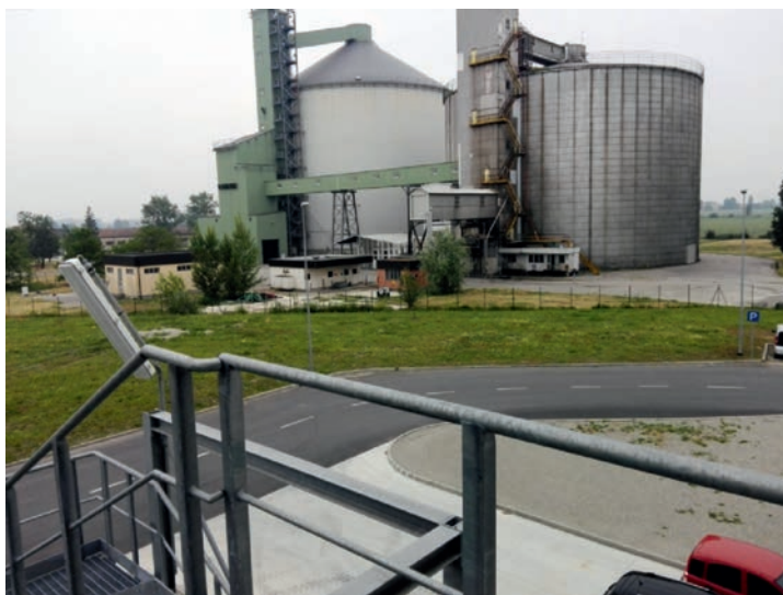
I due silos visti dalla Centrale Elettrica Enel Green Power
